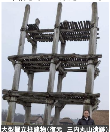
大型掘立柱建物(復元 三内丸山遺跡)
