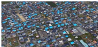
熊本地震の屋根被害によりブルーシートが掛かった住宅
