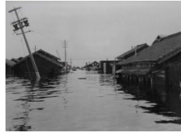
近鉄佐古木駅付近(現弥富市)の浸水の様子
