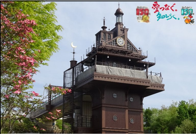
この秋11月1日にオープンするジブリパークの象徴となる青春の丘エリアへの玄関(左奥のブリッジから)、エレベーター塔(一部養生中)です。
