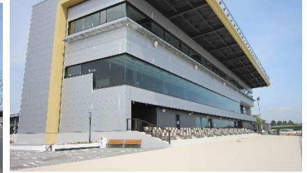
建物コース側外観
