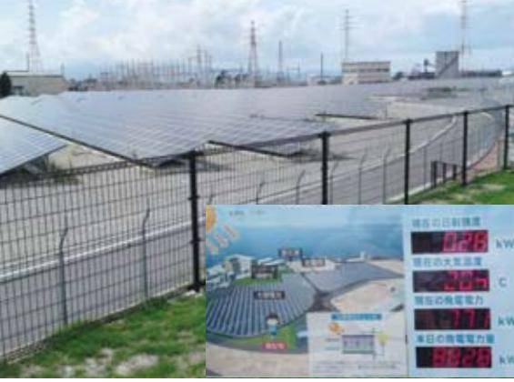
9月5～6日にメガソーラー大牟田発電所(福岡県)、九州シンクロトロン光研究センター(佐賀県)、株式会社アルテミス植物工場(佐賀県)の調査をしました。再生可能エネルギーの一つである太陽光を利用したメガソーラーでしたが、ヤードームとほぼ同じ広さの約8万m<sup>2</sup>の敷地の発電出力は3000kW、60万円/kWと原子力発電の1基約100万kWとの格差が大きいということが実感です。本県のシンクロトロン光施設(電子エネルギー1.2GeV、蓄積電流値300mA、周長72m)と同規模の佐賀県は2度目の訪問ですが、前回未整備の硬X線のビームラインが完成しており期待していましたが思ったより利用が少ないとのことでした。
