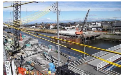
■工事が進む日光川に架かる西光橋
