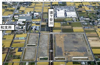
■県企業庁により造成工事が完了する稲沢三宅(平和)の企業団地 明治他の進出が決まり残り1区画を残すのみ
