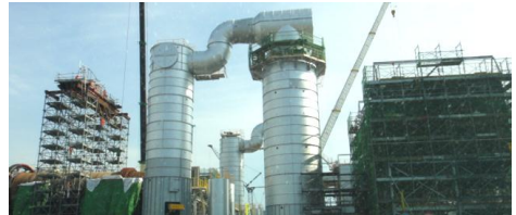
●建設が始まっている焼却処理施設
