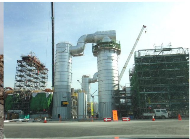
▲建設が始まっている焼却処理施設
