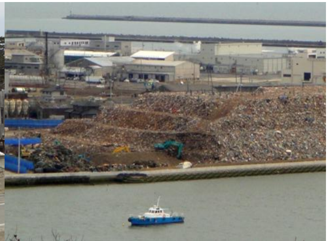
▲敷地の制約から4段積みの仮置き場
