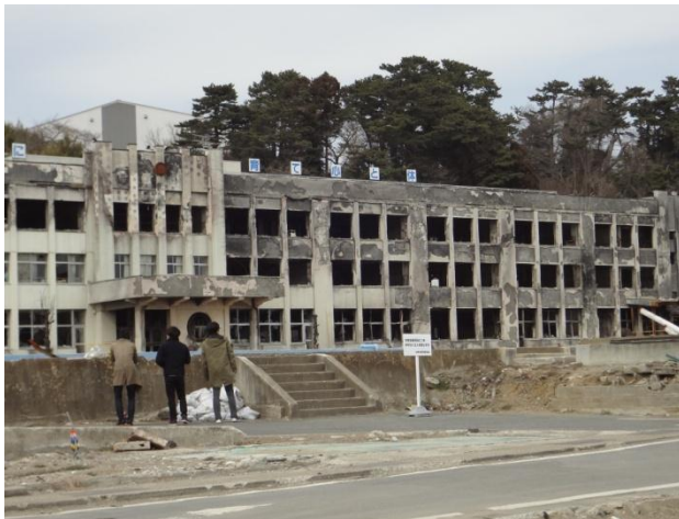
▲津波の襲来の後火災が発生した小学校
